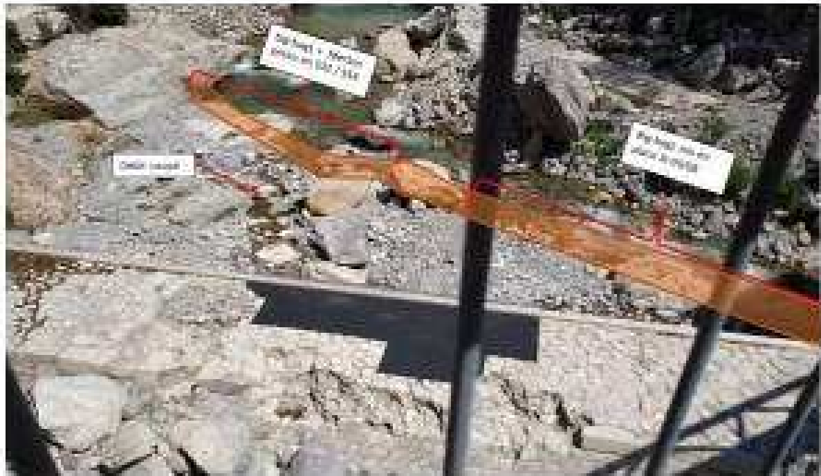
Figure 1 : configuration du cours d'eau fin juillet 2022 – emplacement du merlon à réaliser.
